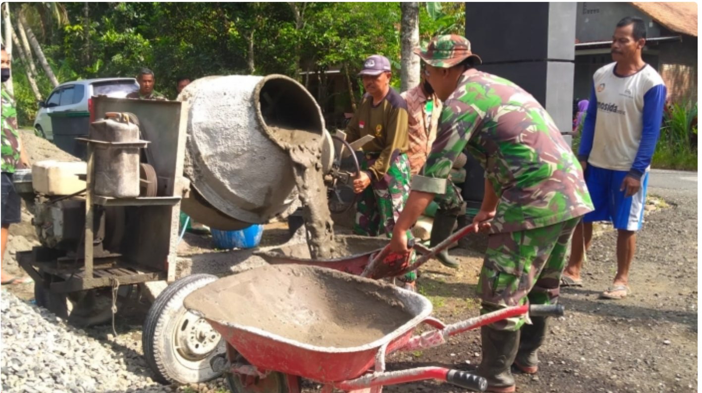
Anggota Posramil Bonorowo Bantu Warga Pengecoran Jalan
